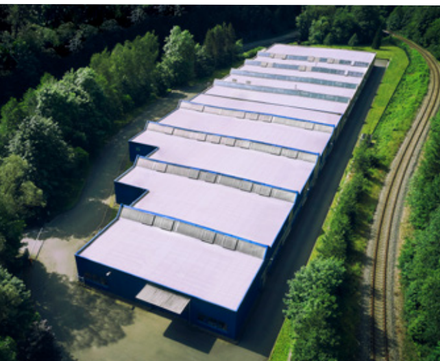
Werk 2 Schwarzatal Elektronikfertigung
