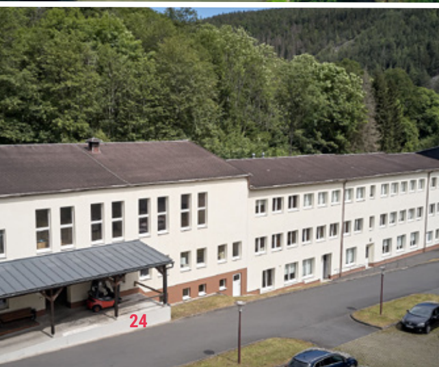
Werk 3 Unterweißbach Transformatorenbau
