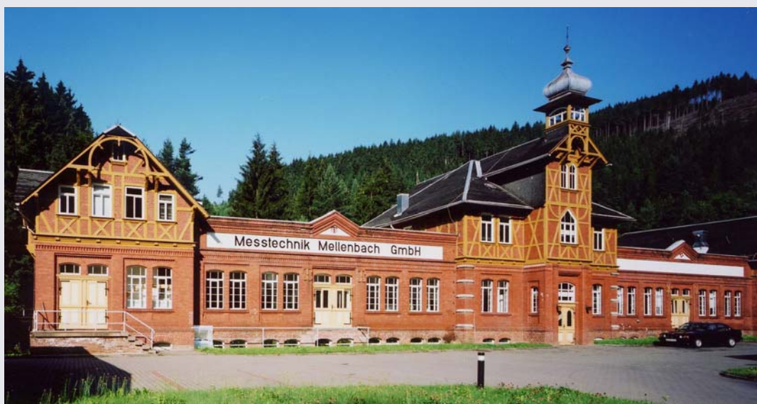
MTM Power, Verwaltung und Entwicklung in Mellenbach / MTM Power, Administration Building in Mellenbach (1991)
